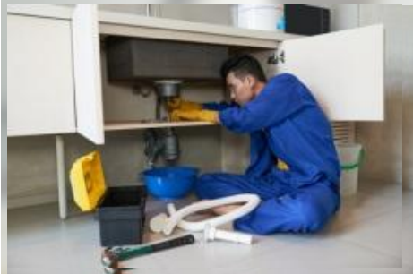
Услуги по производству электромонтажных, сантехнических и сварочных работ
